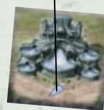
Strona tafli z ukończonym budynkiem
